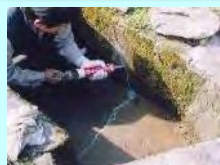
水路のひび割れ補修
