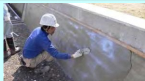
老朽化した水路壁のコーティング
