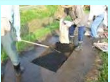
農道の部分補修
