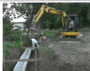
直営施工での水路の長寿命化
