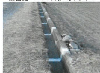
目地詰め補修後の水路
