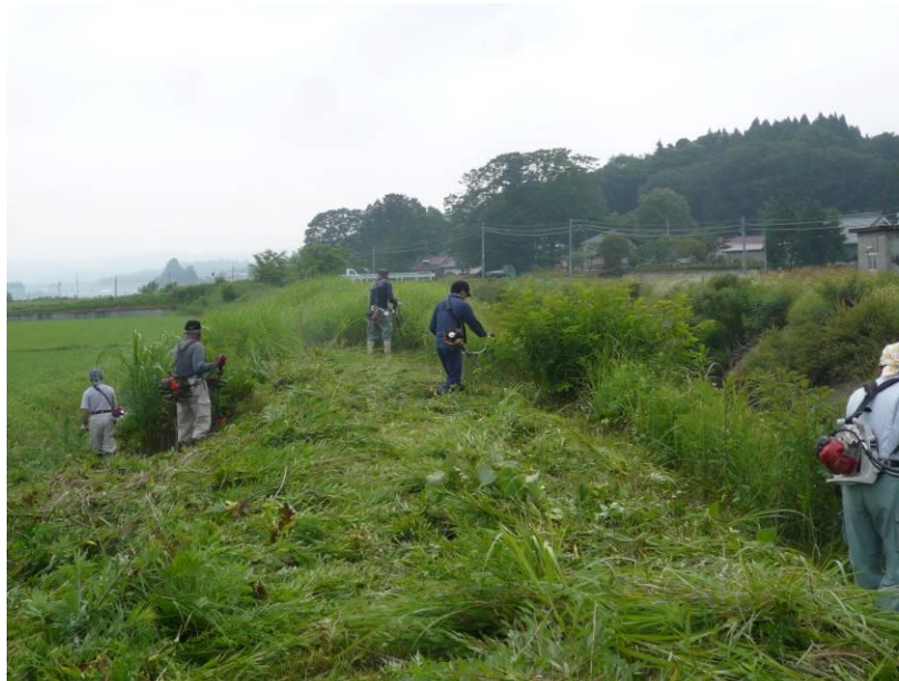
△ 7月1日道路・水路法面の草刈り。（毎年、この時期の草刈りは、大変です。）
